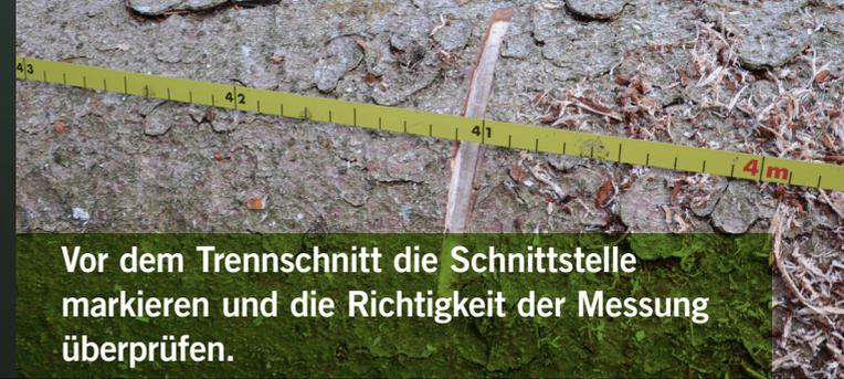
Vor dem Trennschnitt die Schnittstelle markieren und die Richtigkeit der Messung überprüfen.
